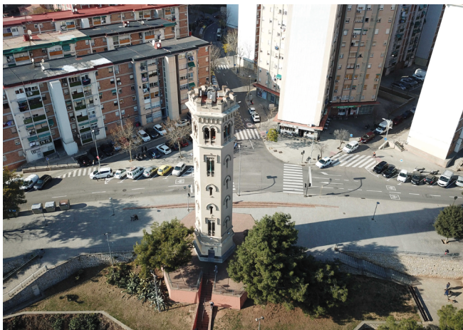
▲ Fotografia de la vista aèria de la Torre de la Miranda. Autoria: Gerard Martí Rodríguez.
